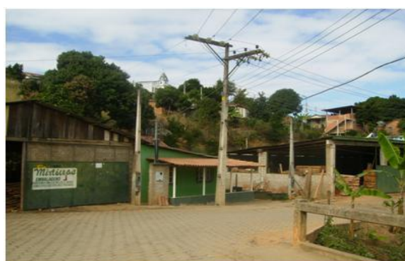
Figura 3.13: Escorregamento próximo a serraria no Bairro Cristo Rei.
